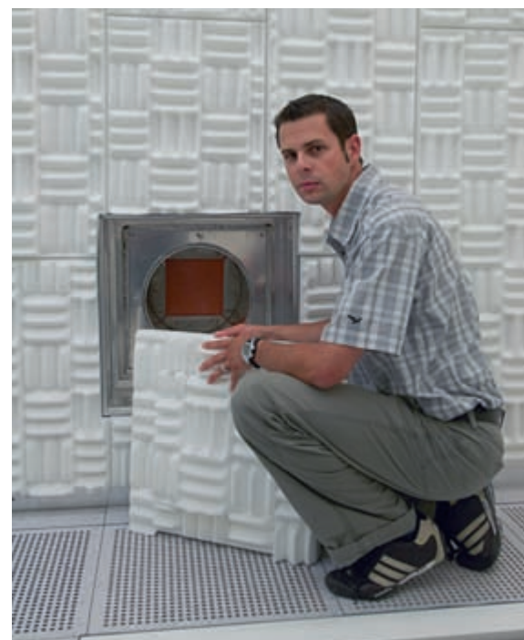
Bild 4 Eine mit schalldämmendem Material abgeschlossene Durchführung vom Experimentier- zum Hilfsbetriebsraum. Die schwingungsentkoppelte Benutzerplattform, auf der Dr. Lörtcher steht, ist an den Wänden aufgehängt.
